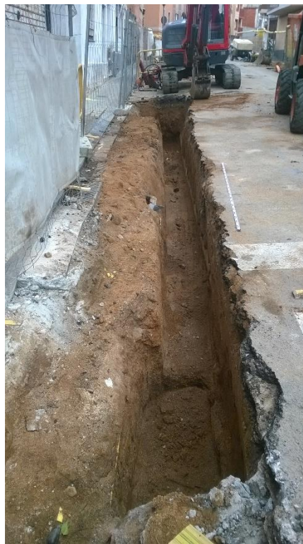
Fotografia 8. Detall del pou 1 i de part del recorregut de la rasa realitzat en aquest tram del carrer Ausona, entre Finestrelles i carretera de Riba.
