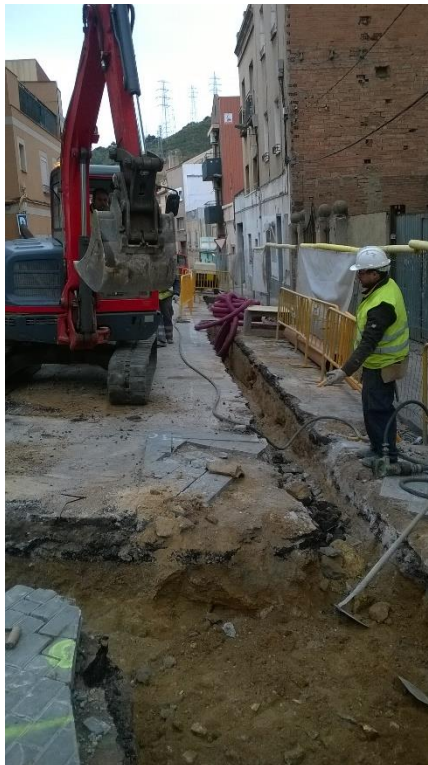
Fotografia 6. Tram del carrer Ausona entre Finestrelles i carretera de Ribes un cop iniciats els treballs.
