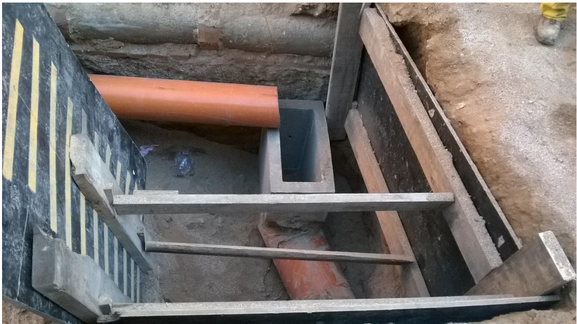
Fotografia 4. Detall de l'arqueta de 1'40x0'90x1'30
