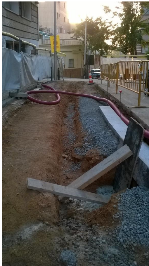
Fotografia 2. Detall de la rasa realitzada per la nova instal·lació de les faroles.
